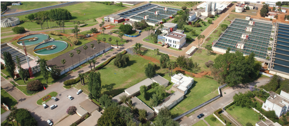
Station de traitement d'Eau Potable Bouregreg-Rabat
