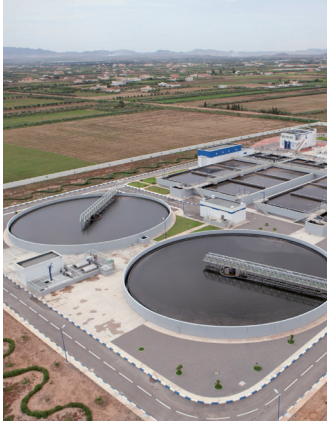
Station d'épuration des eaux usées du Grand Nador
