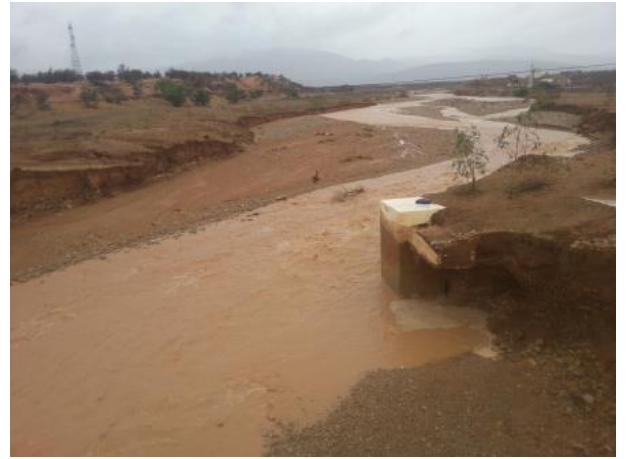
Crue de l'Oued Taguenza ; prise d'eau brute endommagée et conduites emportées
