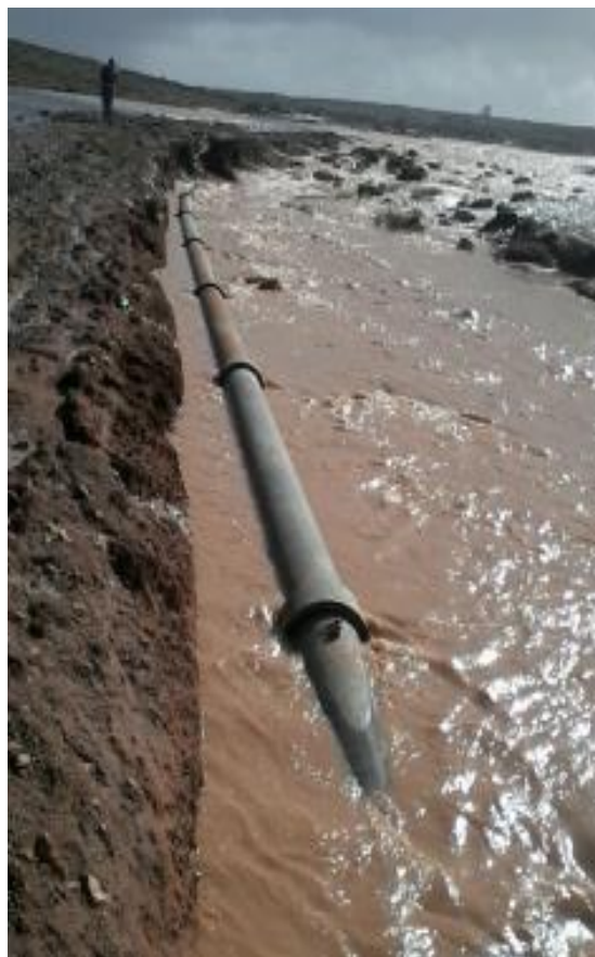
Conduites d'eau emportées par les crues sur plusieurs traversées des oueds entre Tiznit et Sidi Ifni
