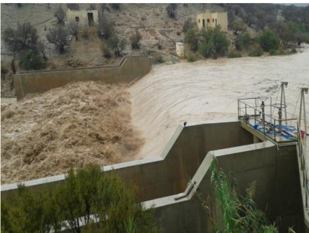
Satation Tamri mise hors service par l'augmentation de la turbidité de l'eau et le colmatage des dégrilleurs au niveau de la prise d'eau brute
