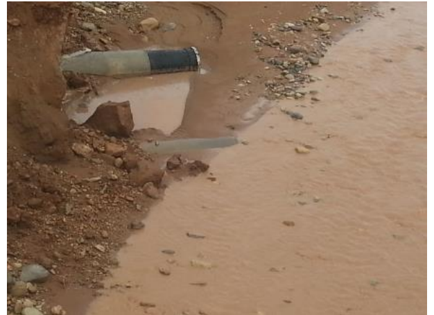
Satation Tamri mise hors service par l'augmentation de la turbidité de l'eau et le colmatage des dégrilleurs au niveau de la prise d'eau brute
