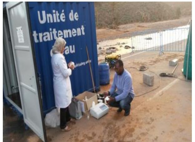
Installation, préparation et raccordement des stations monobloc
