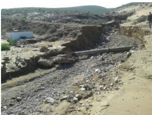
Conduites d'eau emportées par les crues sur plusieurs traversées des oueds entre Tiznit et Sidi Ifni
