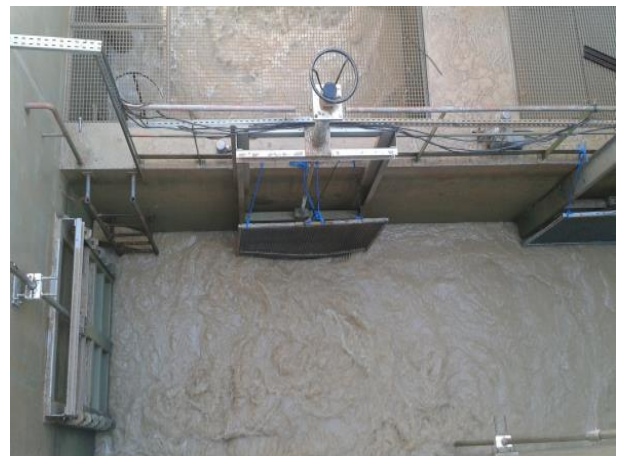
Satation Tamri mise hors service par l'augmentation de la turbidité de l'eau et le colmatage des dégrilleurs au niveau de la prise d'eau brute
